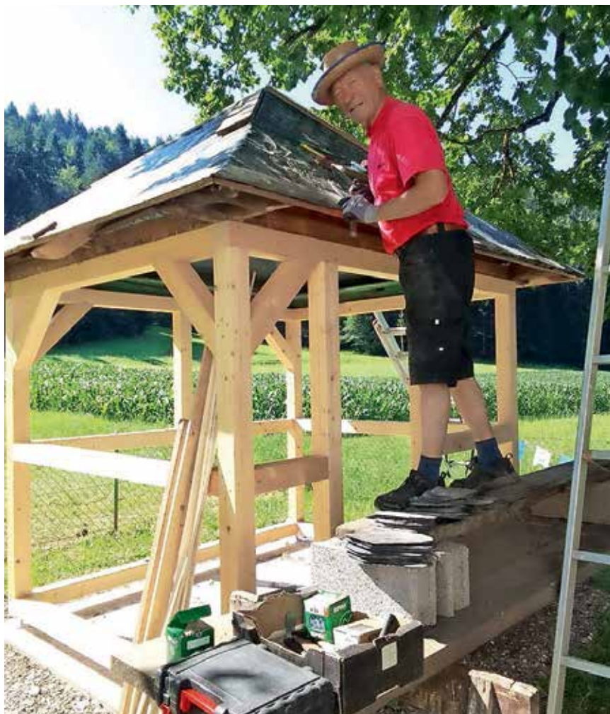
Mojster krovec Miran Benedičič je poleti streho prekril s skrilom. / Foto: arhiv šole
