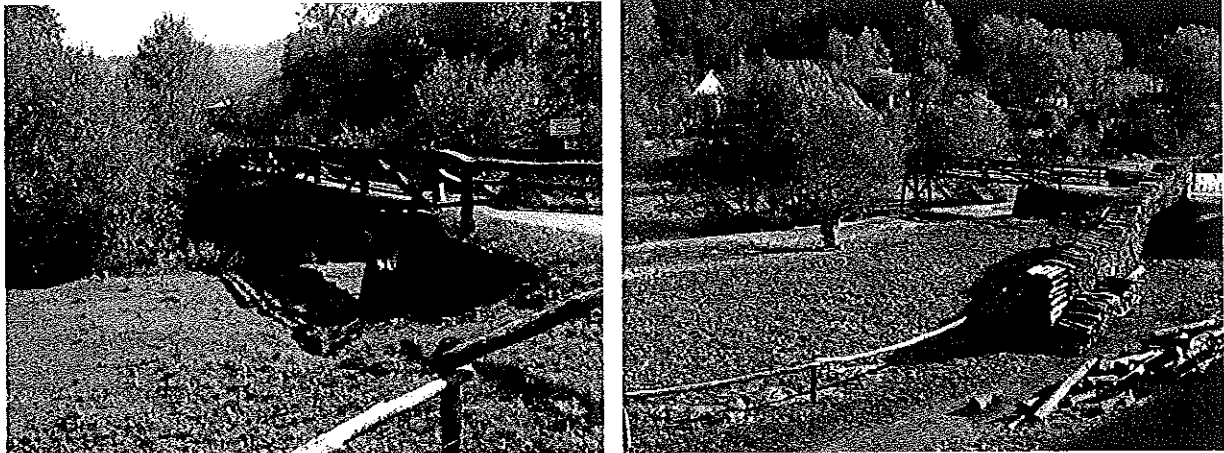
Slika 1, 2: Obstoječa brv v Brodeh in porušena v poplavih oktobra 2014
